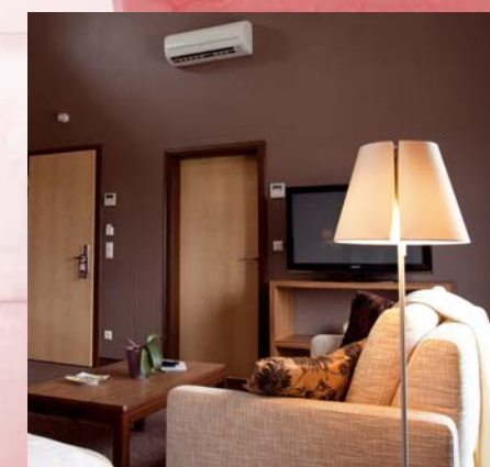
Nach der Komplettsanierung des Schlosshotels in Heusenstamm bekam die Firma Hübner den Auftrag, den gesamten Hotelbereich mit 46 Zimmern, Meetingräumen und Empfangsbereich mit Luftwärmepumpensystemen auszustatten.
