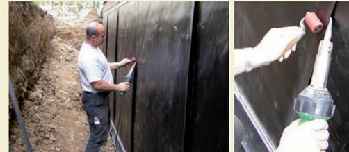
Zu den besonderen Herausforderungen unserer Arbeit gehört die zuverlässige Kellerabdichtung. Um hier ein Beispiel zu geben, verwenden wir für die Vertikalsperre »PVC-P Abdichtungsbahnen«, die an den überlappenden Nahtstellen mit einem Elektroschweißgerät heißluftverschweißt werden. Dieses Verfahren erfüllt nicht nur in vollem Maße die Vorgaben der Abdichtungsrichtlinien, sondern ist als einziges wurzelfestes Verfahren anerkannt.
