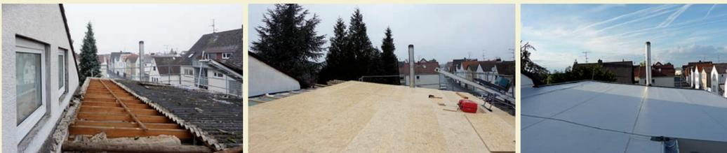
Die früher viel verwendeten »Eternit-Wellplatten« müssen heute nach TRGS-Richtlinien entsorgt werden. Nach der Demontage und fachgerechten Entsorgung der Platten kann anschließend mit der eigentlichen Dachsanierung begonnen werden. Die Sanierung erfolgt in der Regel mit der Herstellung eines neuen Unterbaus, der Dämmung nach aktuellem Stand der Technik und einer Neueindeckung oder Dachabdichtung mit Dachdichtungsbahnen.
