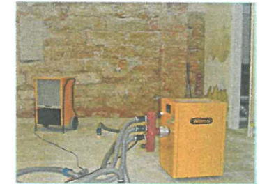
[Trocknung eines Hochwasserschadens]
