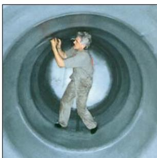
Einbau der Kunststoff-Innenhülle und Montage der Anschlüsse
