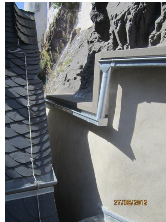
Fertig gestellte Felsabdichtung mit Ablaufrinnen
